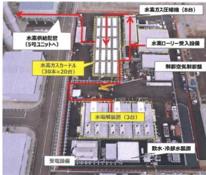
水素発生装置全体
