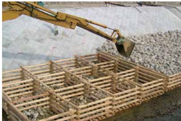
間伐材を土木工事の場で利用する例。
