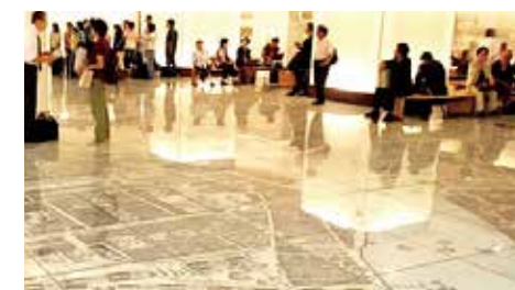
グラスキューブの親会社の三芝硝材の施工例。JR 東京駅地下街の床に張られたノンスリップガラス(上)と硝酸カリウム溶液をガラスに浸透させた化学強化ガラス(右下)。自然破損のないガラスとして注目される。
