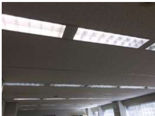
工事箇所の画像
