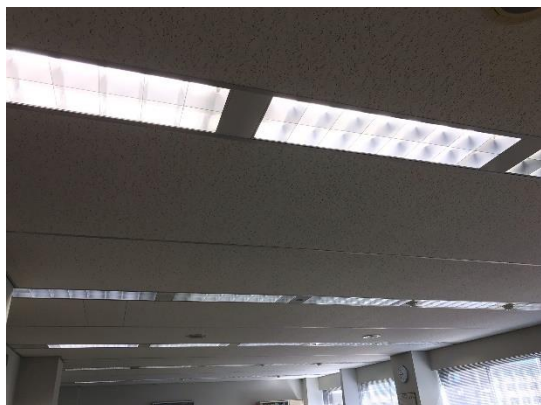
工事箇所の画像
