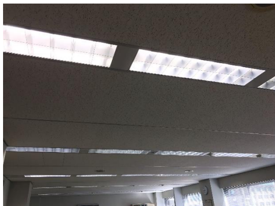
工事箇所の画像
