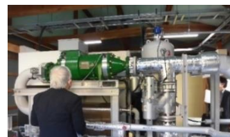
発電施設視察風景 富山県、岐阜県の再生可能エネルギー
