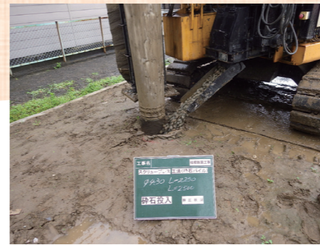
↑ 削孔した後の砕石パイル投入の様子。
