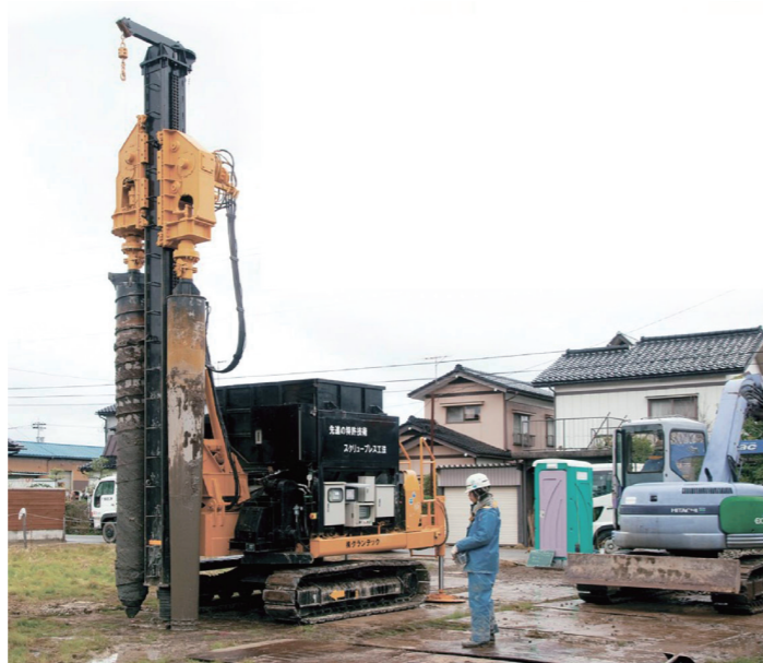
↑ スクリュー・プレス工法の専用機の全体像。排土を出さずに、直径40cm、深さ4mの穴を2分程度で掘削する。操作はラジコンによる。
