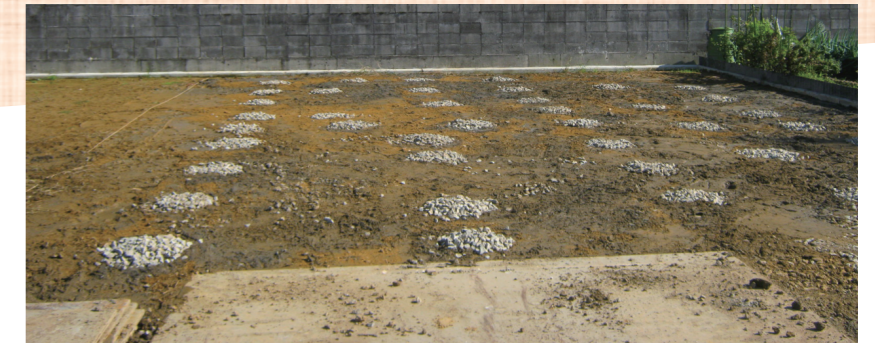
↑ 削孔した後の砕石スクリュー・プレス工法で地盤改良の工事を終えた土地。パイル投入の様子。
